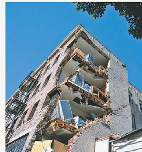
**Figura 4.43.** La corrosión debilita las estructuras y provoca que se derrumben más fácilmente durante un terremoto.
